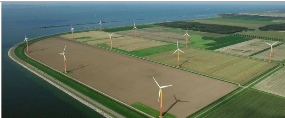
Figuur 1 - Het bestaande windpark Jaap Rodenburg.
